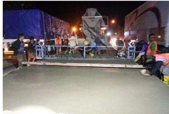
Gambar 1. Kondisi proyek perkerasan jalan Sidoharjo Kecamatan Senori Tuban menggunakan perkerasan kaku (*rigid pavement*)
